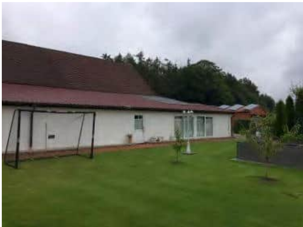
Bild 4: Südseite der Froster-Produktion, Ersatzschallquelle E 4
