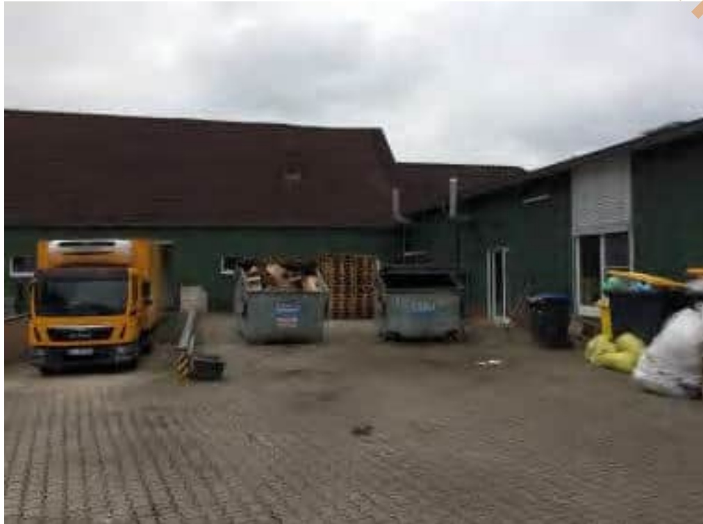
Bild 3: Nordseite der Froster-Produktion, Ersatzschallquelle E 1, E6a und E6b
