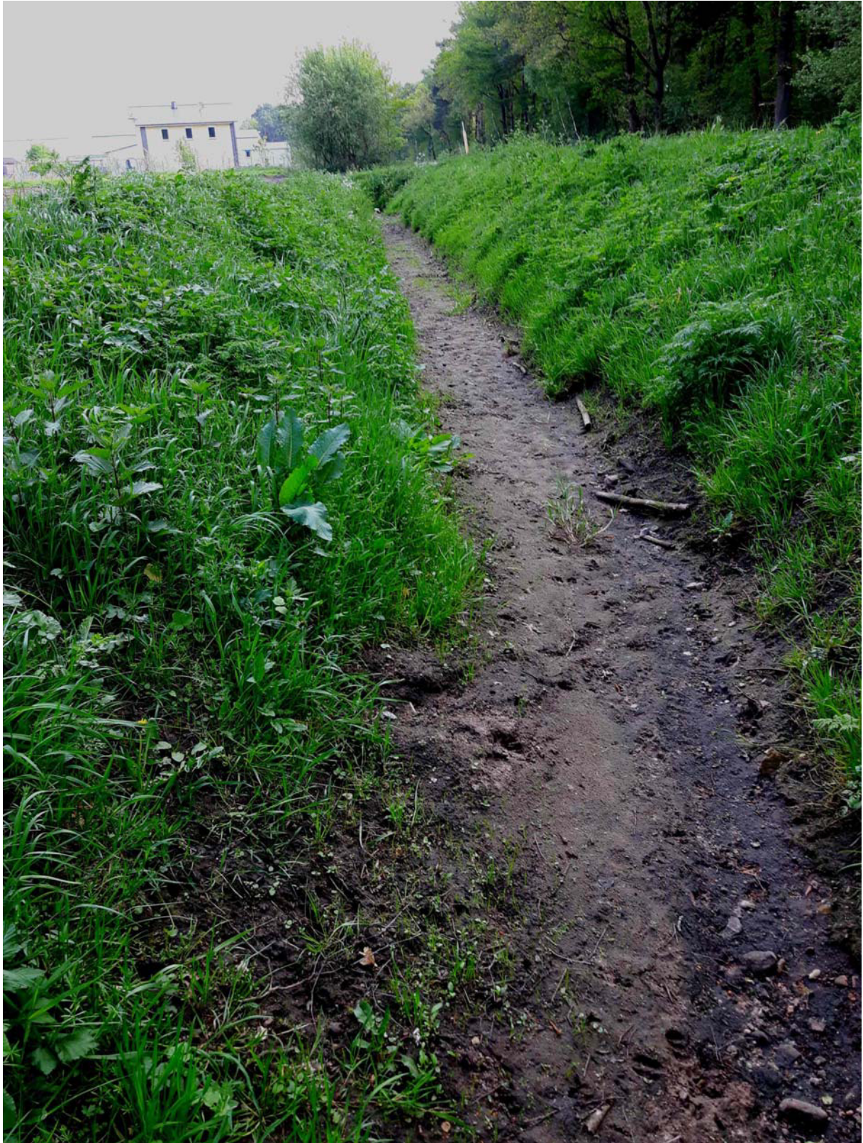
Abbildung 7: Graben westlich des Twickenwegs. Der selbe Zustand wie im vorherigen Graben von Abb. 6
