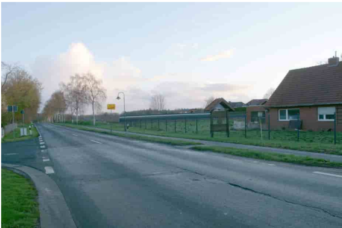
Abbildung 4 L 54 am Ortsausgang, Vorhabenfläche im Hintergrund
